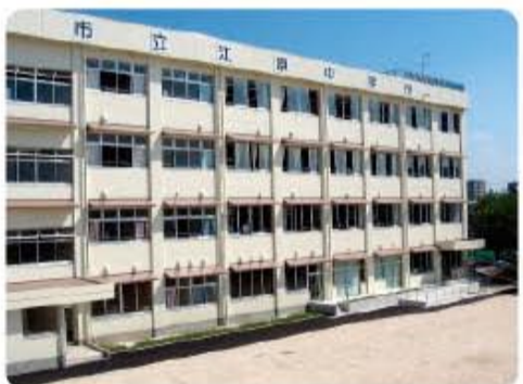
平成23年9月に完成した4階建て新校舎
