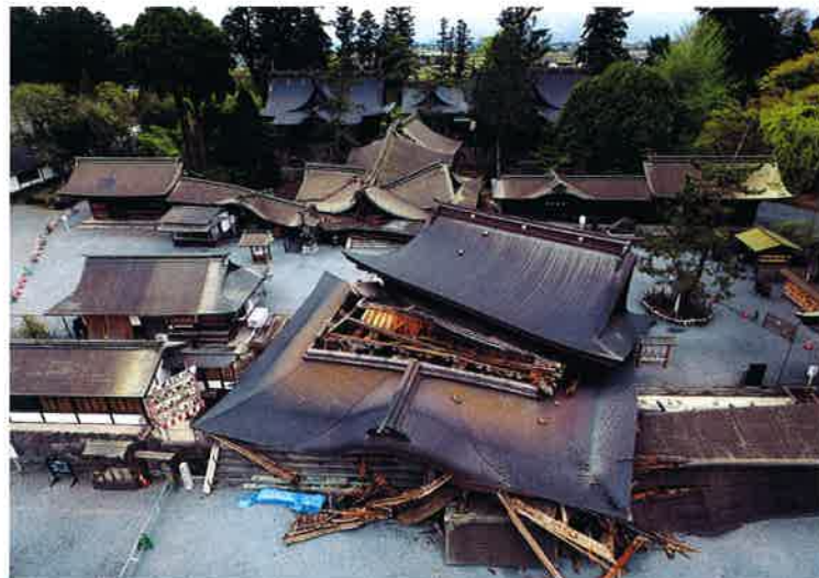
地震で被害を受けた阿蘇神社。拜殿や日本三大大門も崩壊した。 2016年4月18日 阿蘇市 (撮影:共同通信社)
